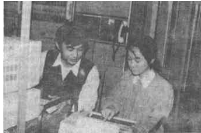
市邮电局加强电信设备管理工作，提高了通信质量。图为机务维护人员通过微机监测设备运行情况。(王锡华摄)
